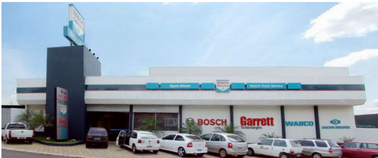
Fachada Matriz Águia Diesel (GO)
