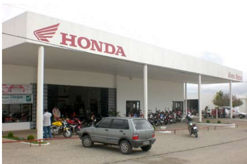
Fachada Matriz Alves Motos
